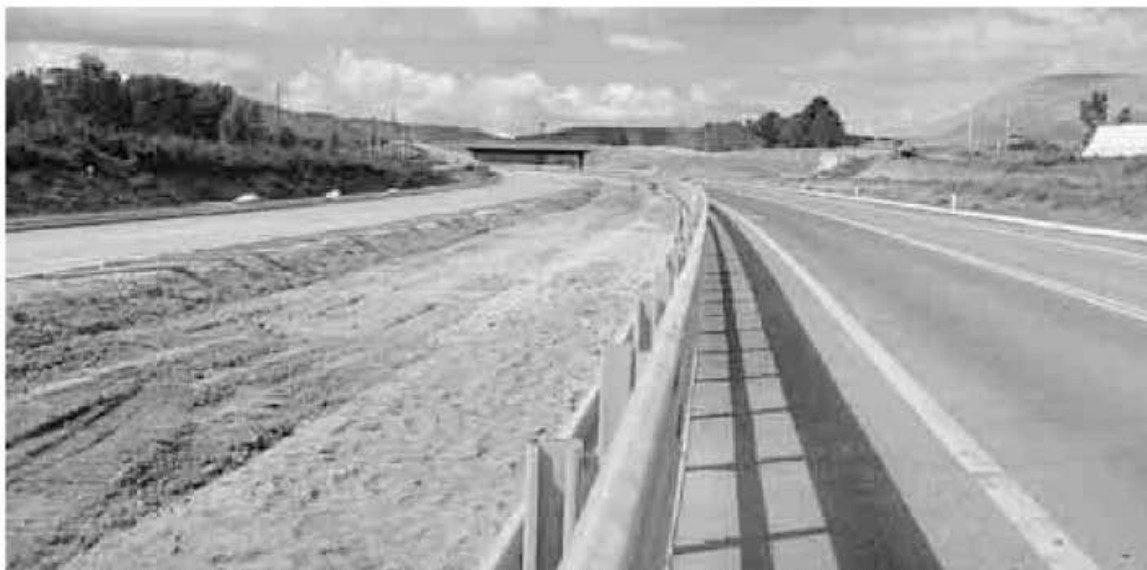
UNA IMMAGINE DELLA BRETELLA CON IL TRATTO COMPLETATO E QUELLO CHE DEVE ESSERE ANCORA ASFALTATO E ULTIMATO
